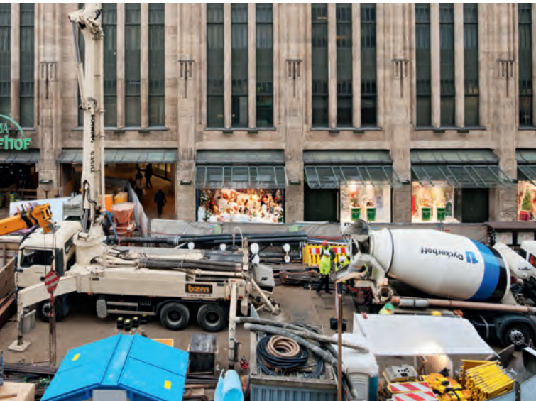
Abladen des selbstverdichtenden Betons in die Betonpumpe
