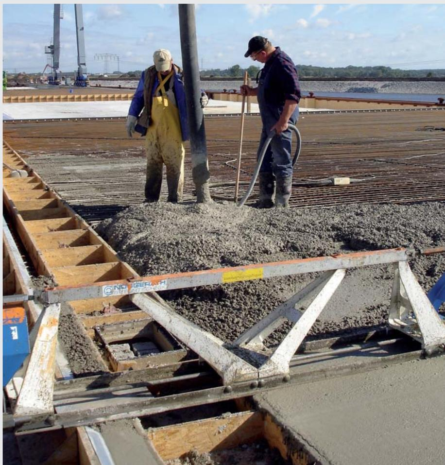
CEM II/B-M (S-LL) 32,5 R aus dem Werk Deuna erreicht, der als Zumahlstoff ein besonders feines Kalksteinmehl enthält. Darüber hinaus konnten weitere positive Eigenschaften dieses Zementes wie das gute Wasserrückhaltevermögen, die dichte Einbindung der Stahlfasern sowie die helle Eigenfarbe (speziell bei Sichtbeton vorteilhaft) genutzt werden.
