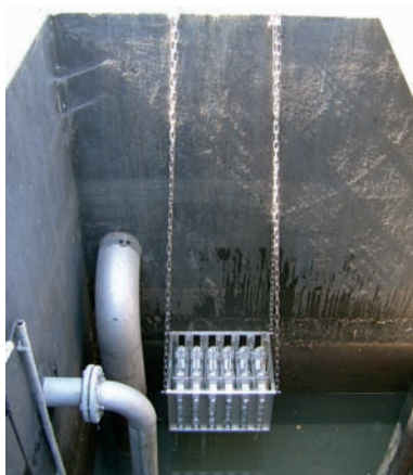
Fig. 9: Vieillissement en compartiment à gaz
