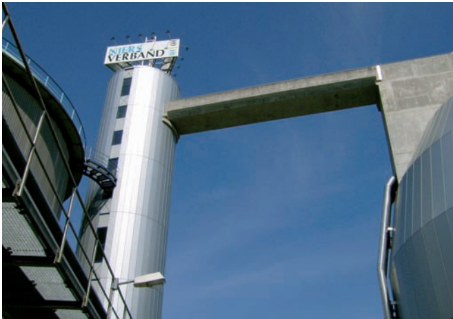
Fig. 7/8: Station d'épuration MG-Neuwerk
