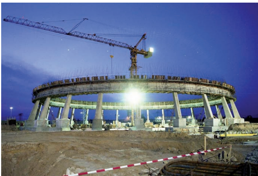
Fig. 13: Tour de refroidissement à tirage naturel de Datteln
