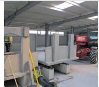
... aus verklebten Elementen
