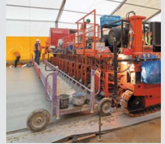
...mit speziellem Fertiger
