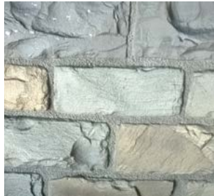
Fugenmörtel auf Basis VARIODUR 50 bei der Talbrücke Höllenbach
