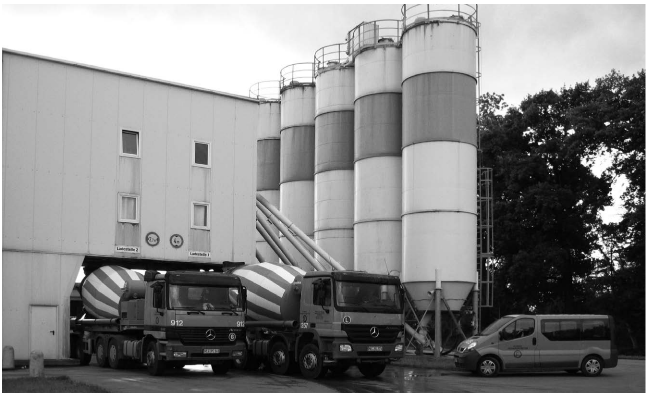
Bild 1: Lieferung von Transportbeton mit dem Fahrmischer
