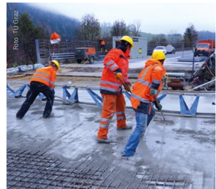
Brückenertüchtigung mit UHPC...
